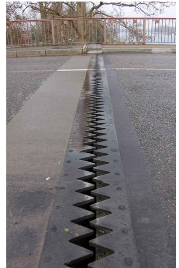
Joint de dilatation thermique d'un pont
